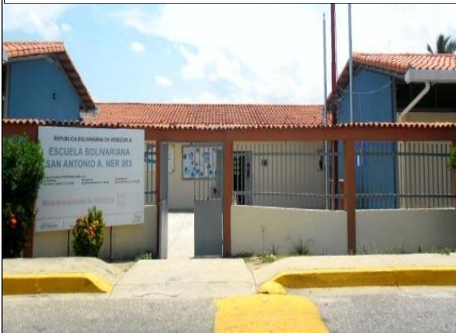
Imagen 1. Fachada de la Escuela Bolivariana San Antonio
