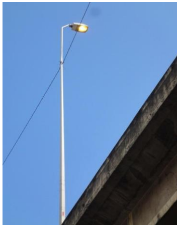
Gráfico 4. Poste y cableados en borde del Distribuidor "La Araña"
